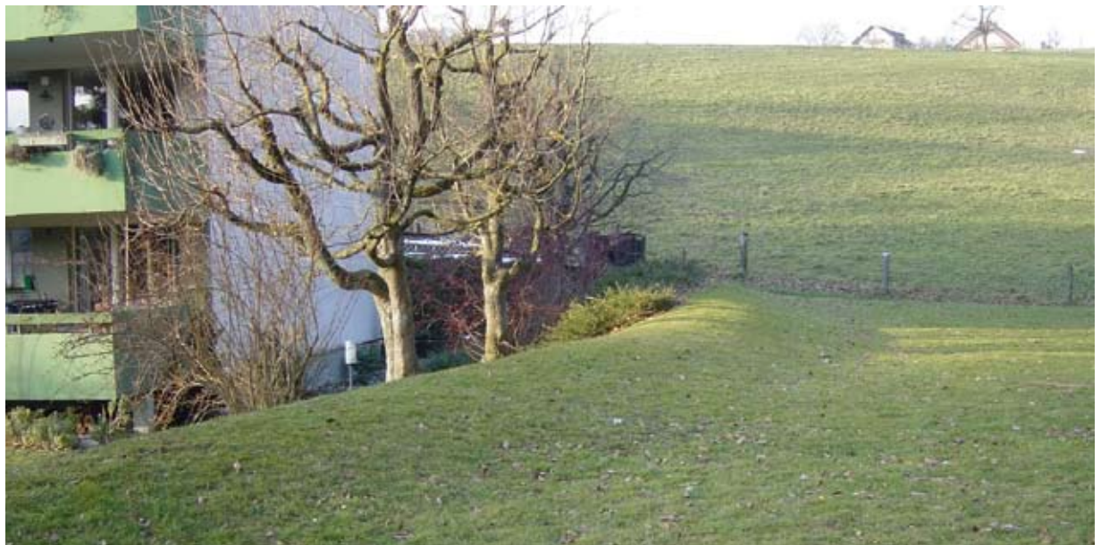
Erdwälle wie hier im Bild leiten das Wasser bei Unwetter vom Gebäude weg.
